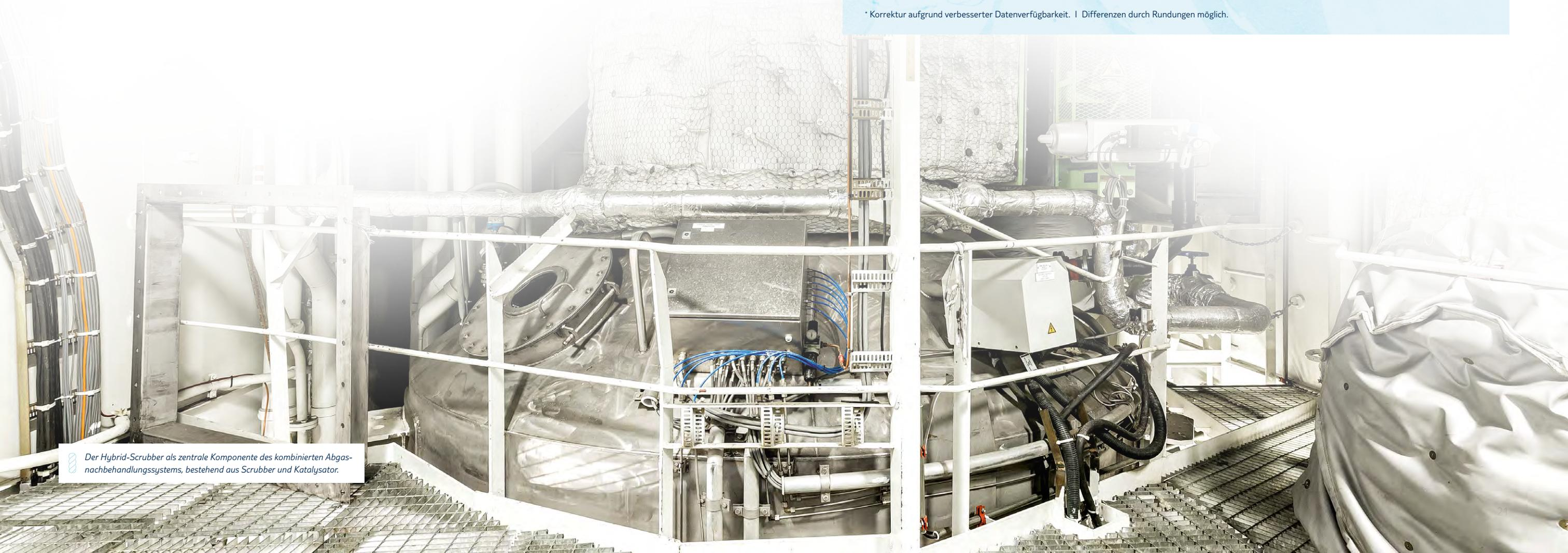
Der Hybrid-Scrubber als zentrale Komponente des kombinierten Abgasnachbehandlungssystems, bestehend aus Scrubber und Katalysator.
